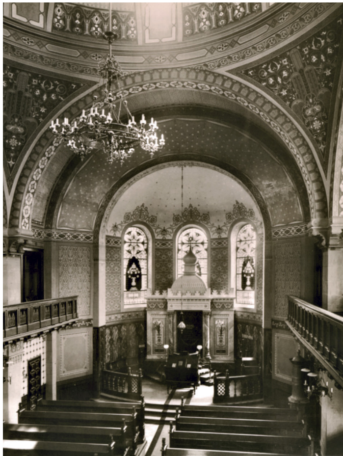
Abb. 19: Synagoge, Innenraum in östliche Richtung gesehen, Pforzheim, ca. 1895.
