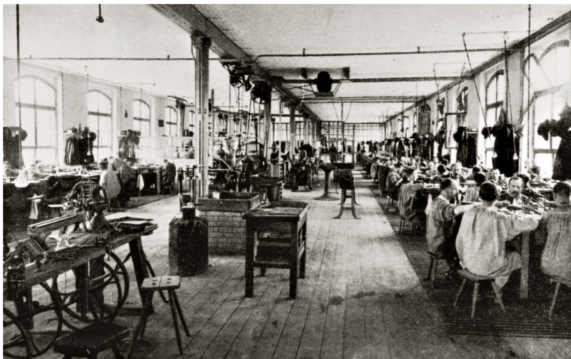
Abb. 14: Fabriksaal der Firma Louis Kuppenheim, Durlacher Straße 69, Pforzheim, um 1905.
