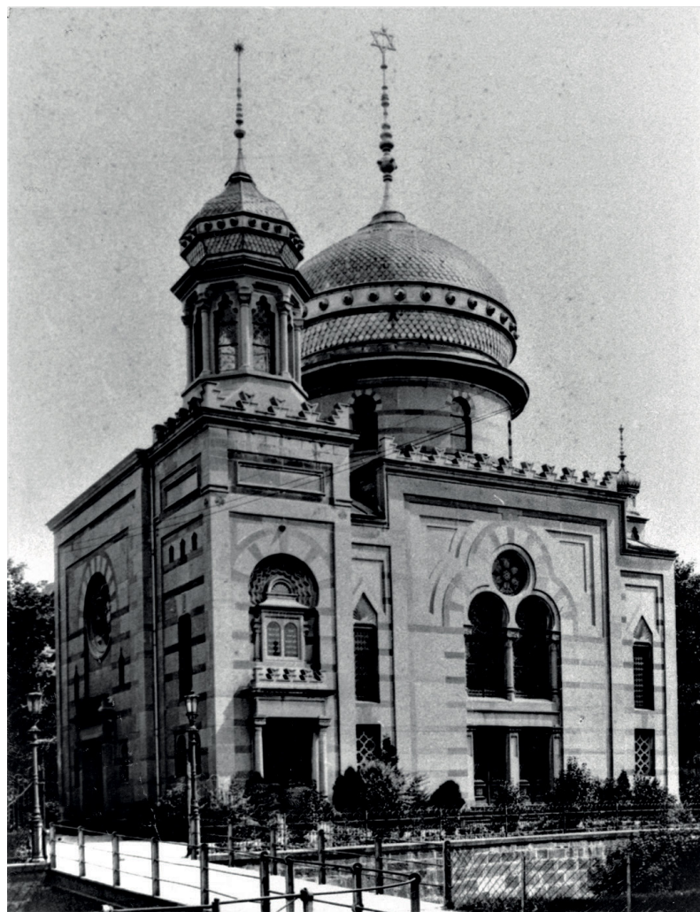
Abb. 16: Synagoge, Südwestansicht, Zerrennerstraße 28, Pforzheim, ca. 1895.
