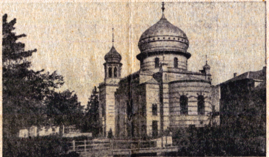
Die Synagoge von Pforzheim (an der Zerrennerstraße), die im November 1938 völlig zerstört wurde.
