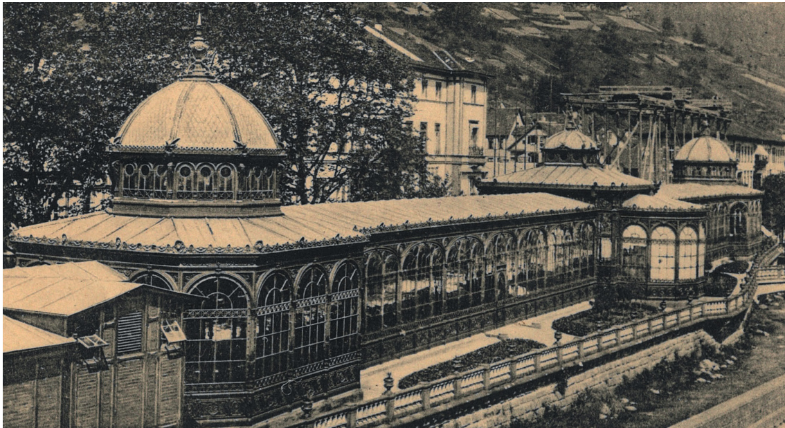
Abb. 20: Von den „Buden“ im Kurpark, in denen Mitte des 19. Jahrhunderts Waren verkauft wurden, gibt es keine Aufnahme. Aber auch nach dem Bau der Alten Trinkhalle 1879 setzten hölzerne Verkaufsbuden (ganz links im Bild) die Tradition der Sommerverkaufsstellen fort, Foto ca. 1890.
