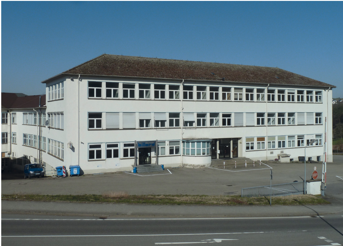
Abb. 5: Das ehemalige Lufag-Hauptgebäude im Jahr 2020.
