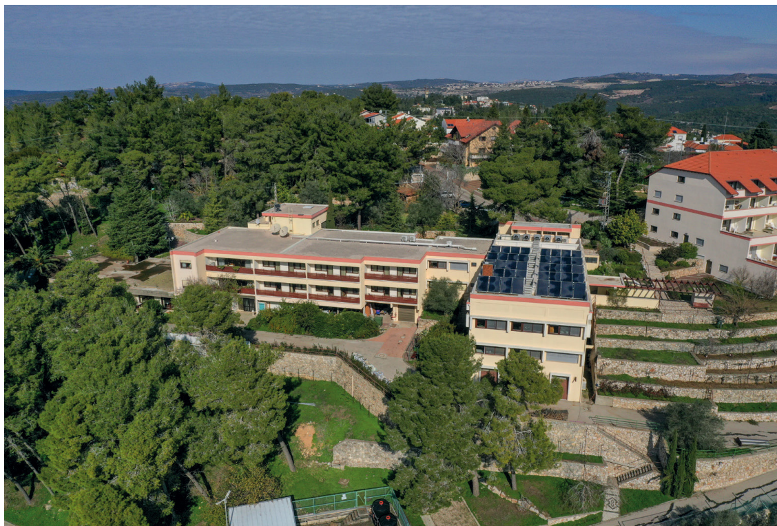
Abb. 9: Luftaufnahme des Altenpflegeheims Beth Elieser in Maalot/Israel, 15.01.2019.
